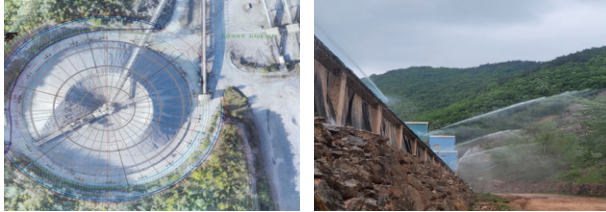
영월광산 상옥설비 설치
