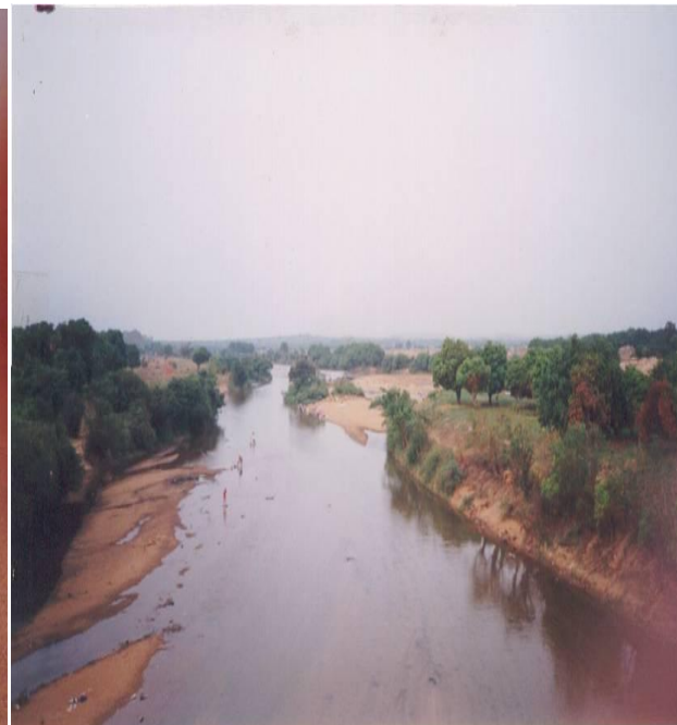
Photo 7: dégradation des berges du Niger
